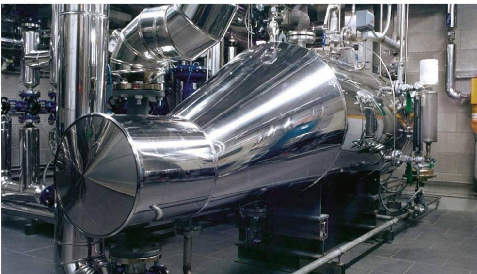
کلیه عملیات مربوط به طراحی و ساخت مبدل های بخار تمیز شرکت سیستم های انرژی فردا مطابق با استاندارد EN285 انجام می شوند. این مبدل ها برای ایجاد بخار تمیز بر اساس استاندارد HTM 20.31 طراحی و تولید شده و تمامی قسمت های در تماس با بخار تمیز از جنس فولاد ضد زنگ ساخته می شوند. به عنوان منبع انرژی می توان از بخار خروجی استاندارد دیگ بخار، روغن داغ یا آب داغ استفاده نمود.
